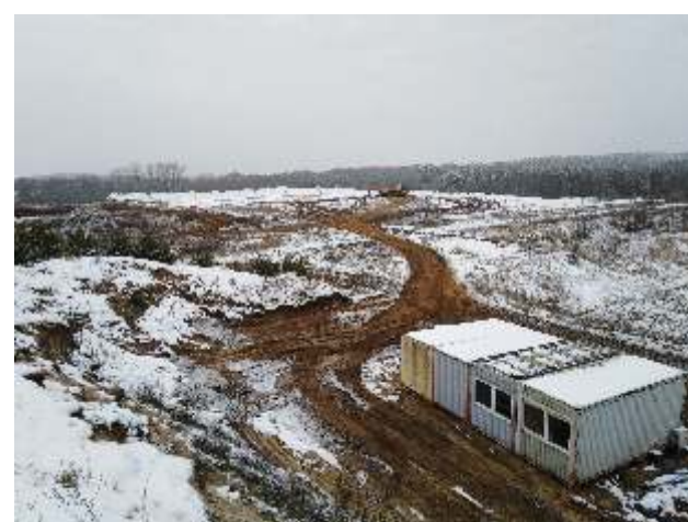
Plac budowy kwatery 1C (ZUOK Długoszyń), styczeń 2021
