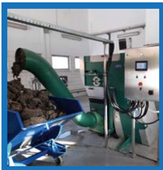
Stacja Uzdatniania Wody w Sulęcinie
