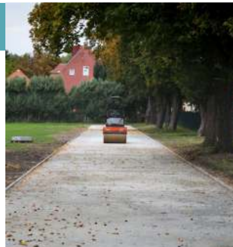
Bieżnia powstaje na szkolnym dziedzińcu.
